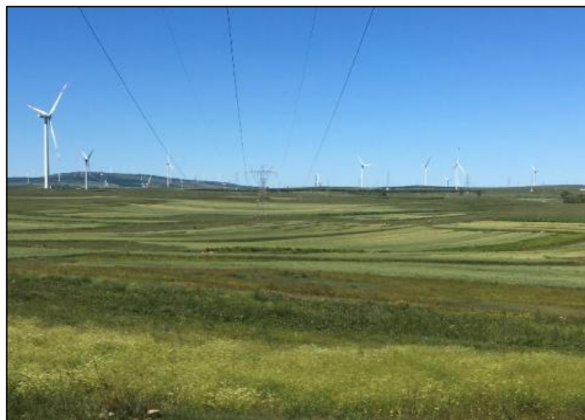
线路塔基附近生态恢复照片
