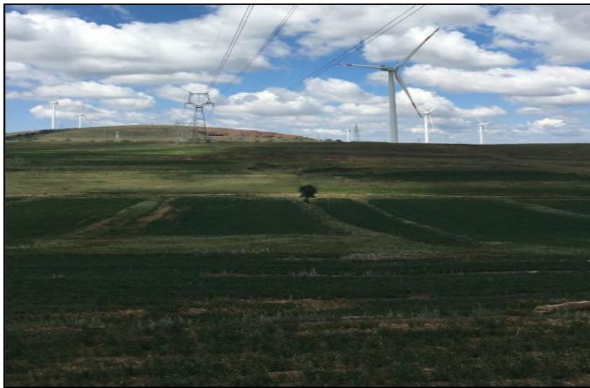
线路塔基附近生态恢复照片
