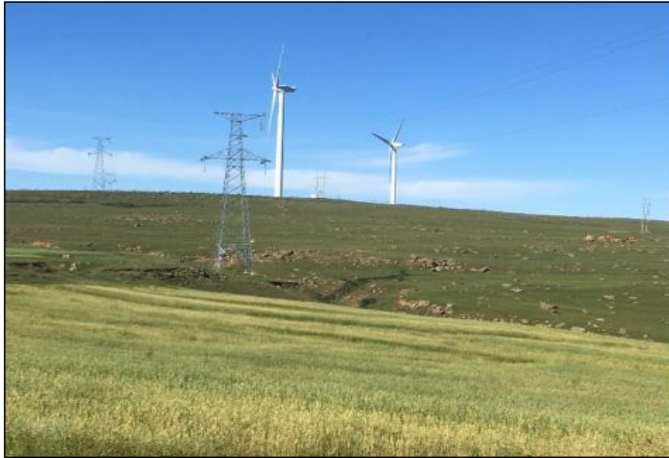
线路塔基附近生态恢复照片
